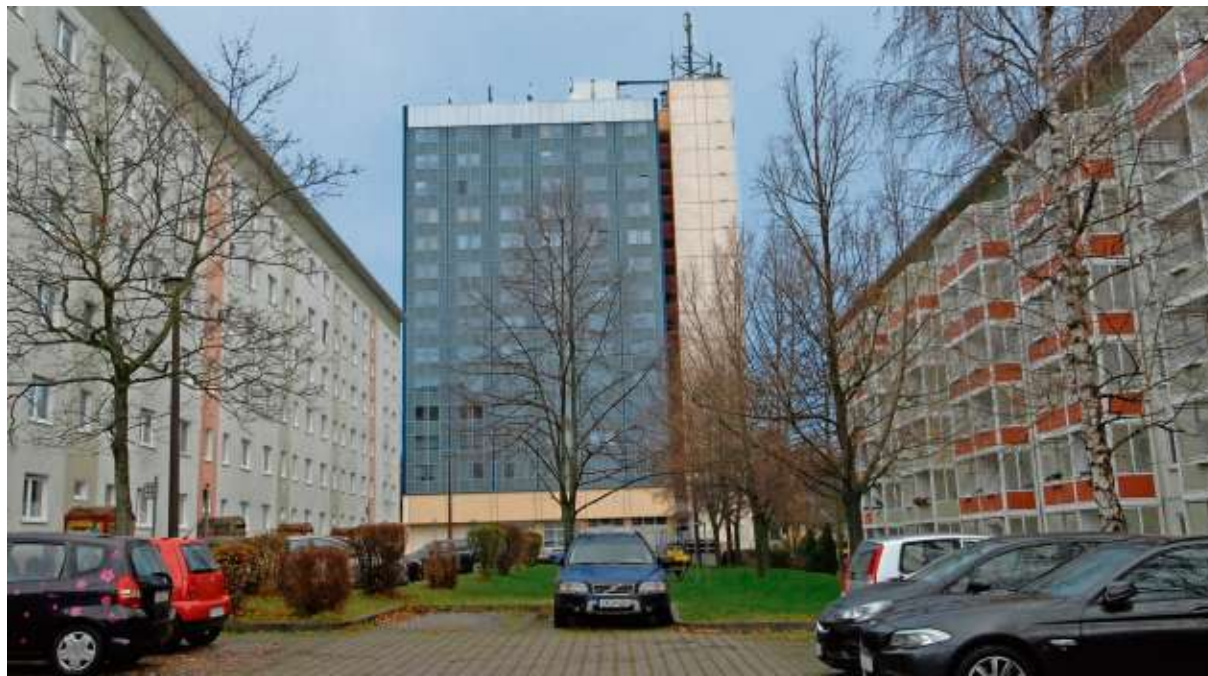
50 Meter hoch mit 13 Geschossen und 94 Wohnungen: Das Hochhaus am Stollen ist für Ilmenau einzigartig. Foto: b-fritz.de
