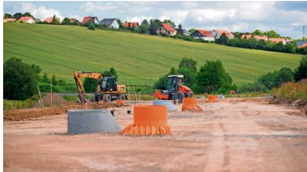
Die Erschließung im Wohngebiet „Friedhof West“ geht voran mit dem Bau der Zufahrtsstraße (im Bild) und dem Lärmschutzwall zur Abgrenzung von der Erfurter Straße. Im Hintergrund der Oberpörlitzer Habichtsfang – ein Baugebiet, das vor etwa 20 Jahren erschlossen wurde. Foto: Andreas Heckel
